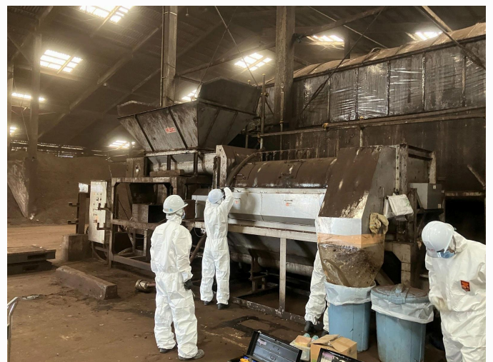
写真：1号機移設作業
