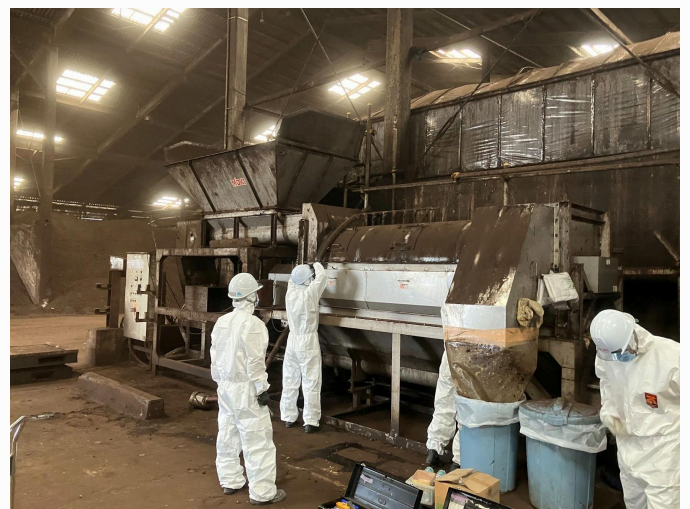
写真：1号機移設作業
