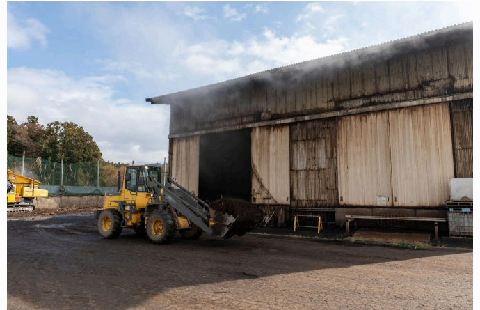
写真：堆肥原料の受入口（施設全体図③）。汚泥、木くず、破袋分別後の生ごみがここから投入される
