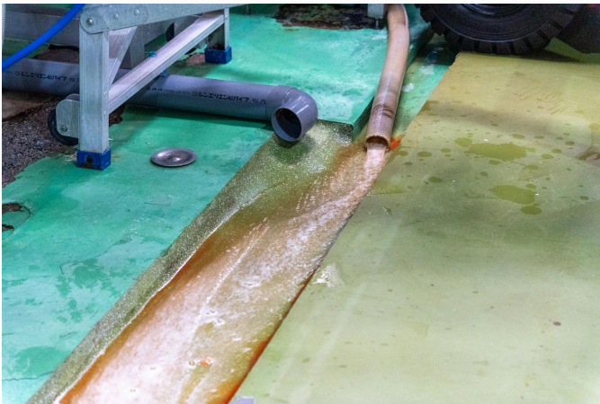
写真：分別された廃ジュースは工場内の排水溝を流れ排水処理施設へ
