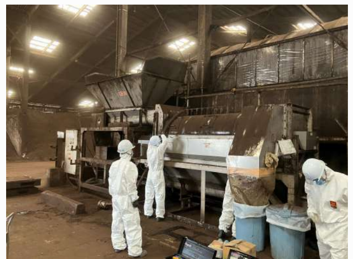
写真：1号機移設作業
